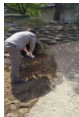
築山の土管の中の土砂の掻き出し
